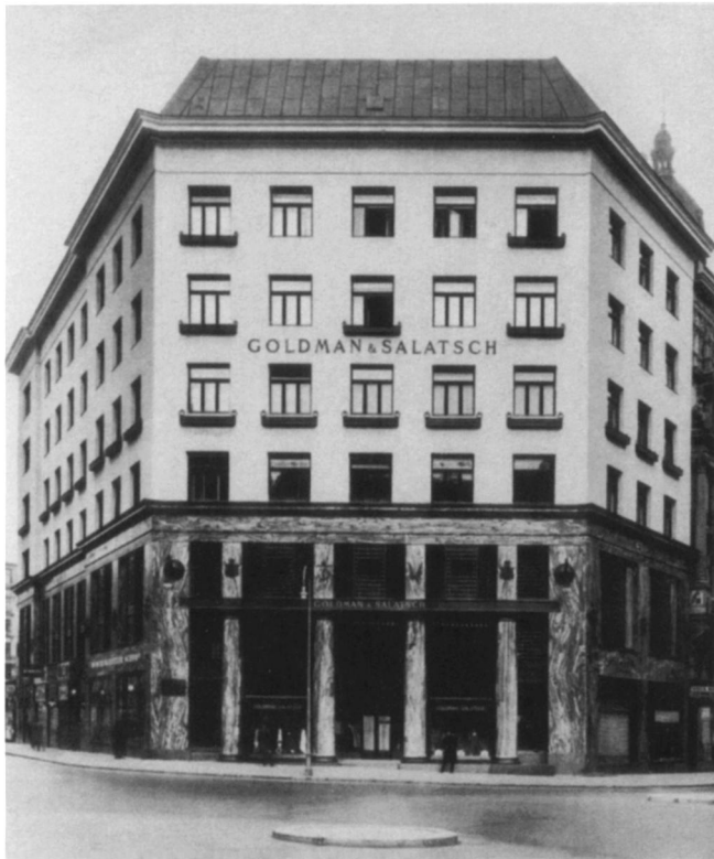
28. Loos, Haus on the Michaelerplatz, Vienna, 1910, exterior
